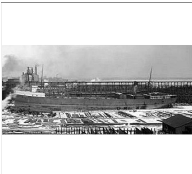
Skibet under opbygning
